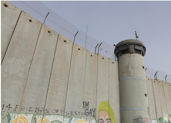
Die Sperranlage Israels, hier bei Bethlehem.
